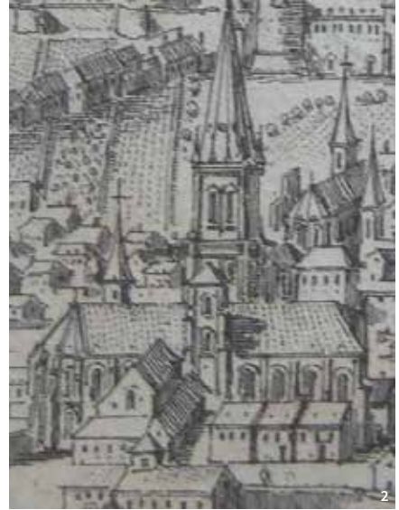
2. Sébastien Pontault de Beaulieu, Bar-le-Duc, (détail), estampe, XVII e siècle, Musée barrois, Bar-le-Duc. On devine les deux tours clochers aujourd'hui détruites, dont les larges piles porteuses sont encore visibles dans la nef.
