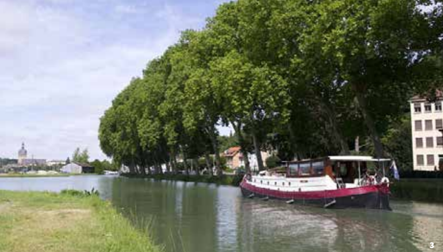
3. Le canal de la Marne au Rhin depuis le pont de la rue de Saint-Mihiel à Bar-le-Duc © G. Ramon
