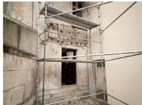
éviction de l'enduit sur lattis en cours sur une façade à pan de bois
