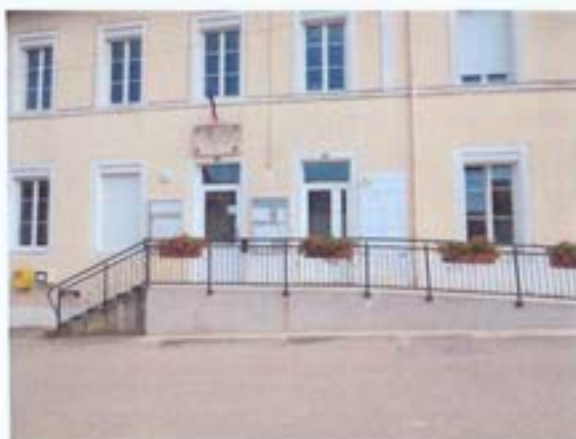
Aménagement d'une rampe d'accès – mairie de Menaucourt
