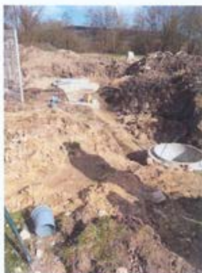
Travaux de pose de mise en place du réseau d'assainissement non collectif (Givrauval)
